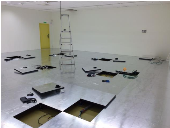
Bild 4 Installationsgolv, montering av aktiv elektronik (AV-teknik)
